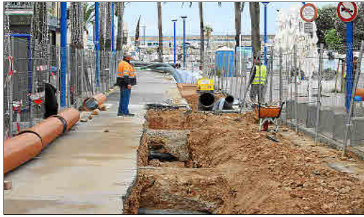
Los trabajos finalizarán antes de Semana Santa. Fotos: MICHELS
